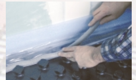
Randstreifenabdichtung mit PE-Schaum-Rundprofil
