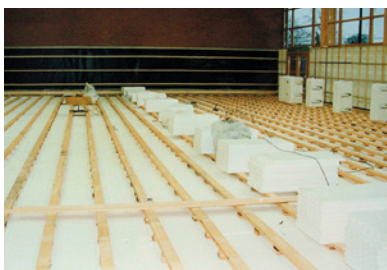
Ausgelegte Systemplatten zwischen den Doppelschwingträgern
