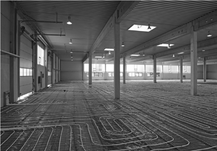
Bild 2: Betonkonstruktion mit Mattenbewehrung
